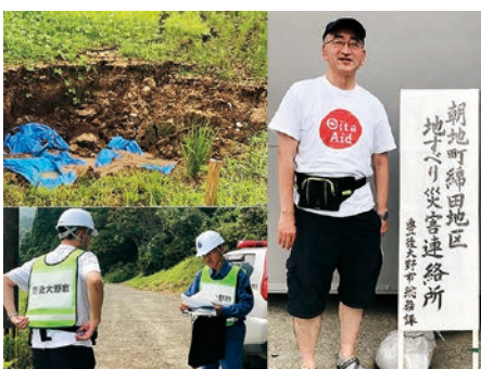
朝地町綿田地区の地割れの様子を見学させて頂きました
